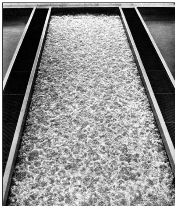
شکل شماره ۶-۲۶ - یک فیلتر ماسه ای تند در حال بکواش با استفاده از هوا (دگرمون ۱ )
