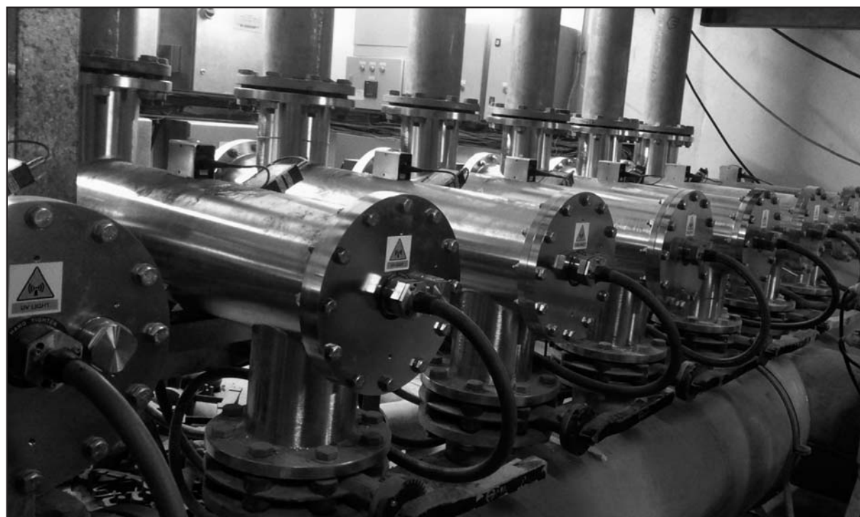
شکل شماره ۸-۱۵ - تاسیسات میکروبی‌کشی یا پرتو فرابنفش در ظرفیت‌های زیاد
