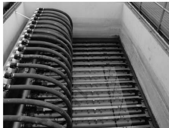
شکل شماره ۶-۸- تاسیسات میکرو فیلتر
