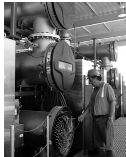
شکل شماره ۶-۱۰- تاسیسات پرتو فرابنفش
